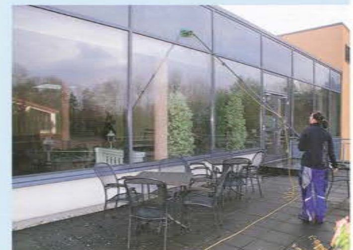
Mit dem Stangensystem lassen sich nicht nur hohe, sondern auch zugestellte Glasflächen komfortabel reinigen.
